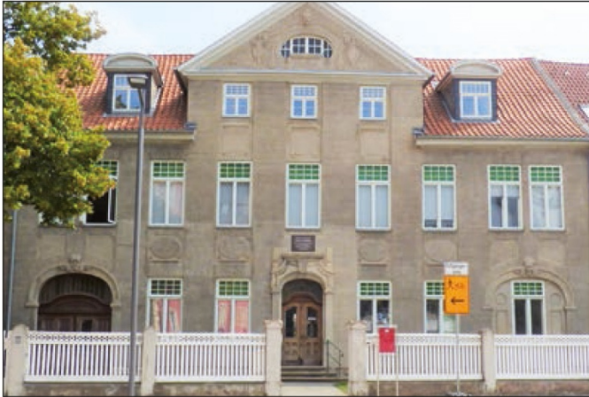
Bild2 : Fassade des Hauses Schlossplatz 4.
