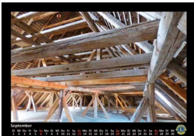
Bild 27: Kalenderblatt für den Monat September: Dachstuhl des Kornspeichers, Schloßplatz 8a.
