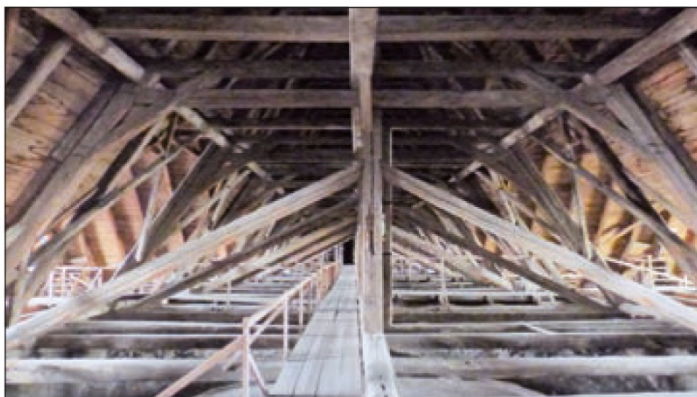
Bild 24: Dachstuhl in der Hauptkirche.
