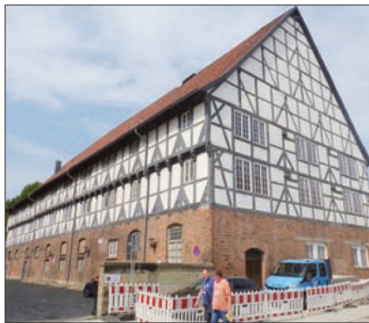
Bild 26: Kornspeicher, Schloßplatz 8a.
